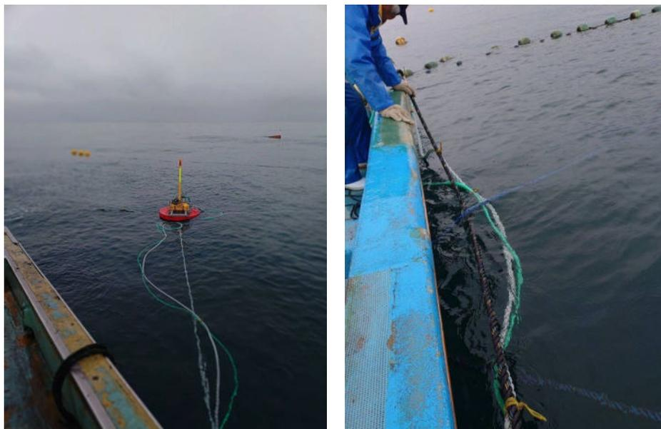
図表 5. II-8 水中映像伝送システムの設置作業の様子
