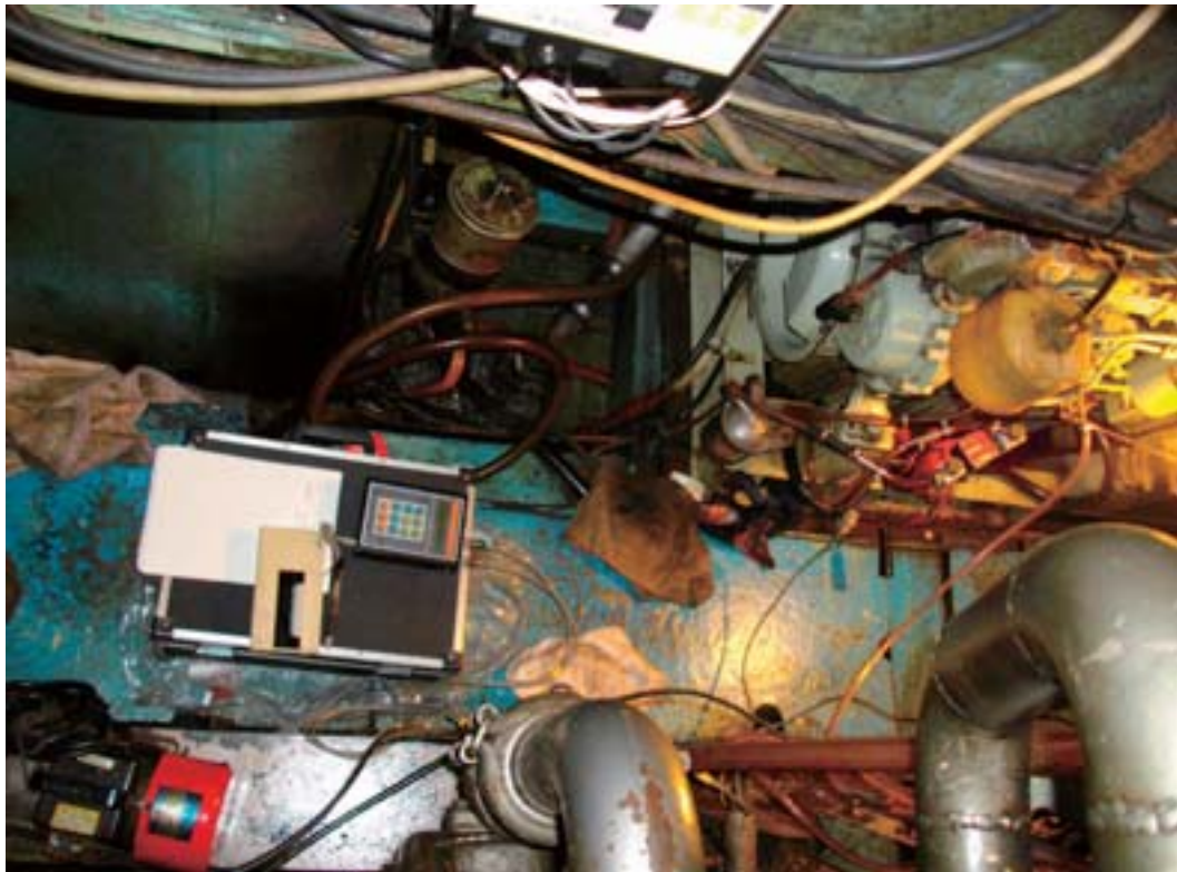
「写真 13：計測の様子」
