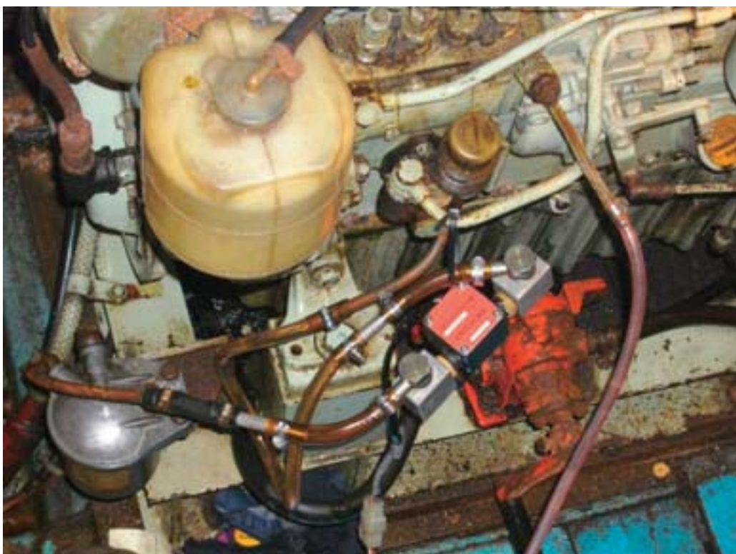
「写真 11 : 燃料流量計の取付」
