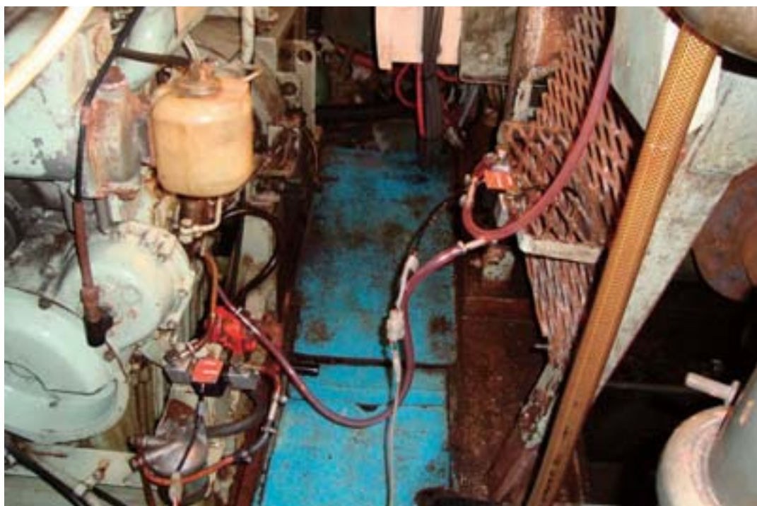
「写真 12 : 右側タンク」
