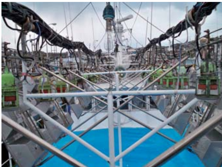
「写真5：パイプによる支持」
