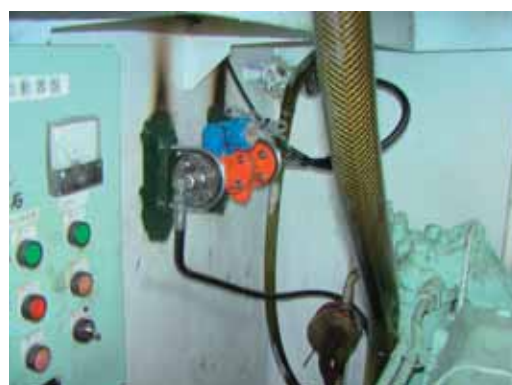
(写真11) 補機3 流量計
