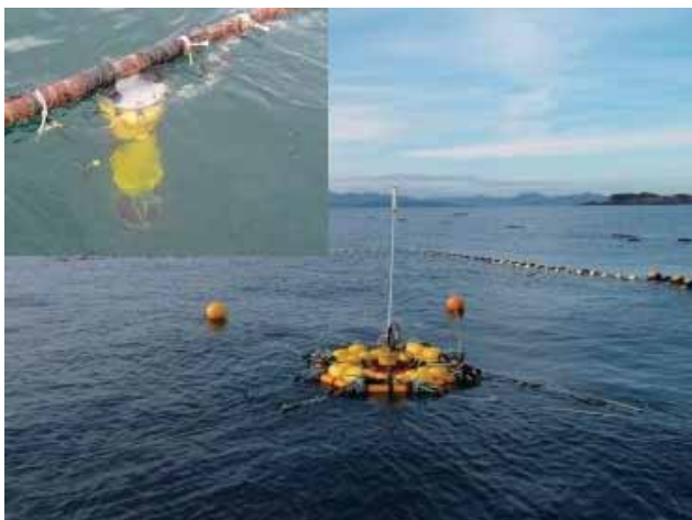
写真8 アンテナ通信部 (海上設置状況).
